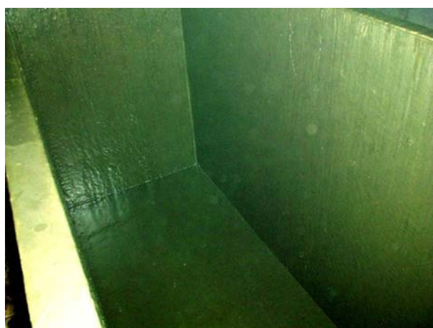
Фото 2 Гальванический цех: - ванна, защищенная «Ремохлор». - ванны, которые внутри защищены «Ремохлор», снаружи «Унитек»
