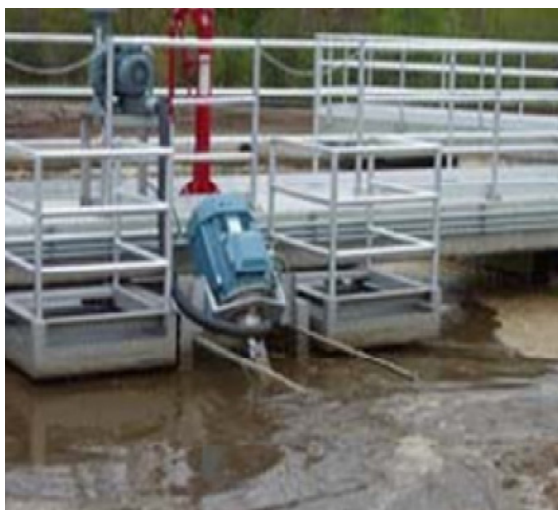
Рис.6 Простота и безопасность в содержании и осмотре аэраторов благодаря сервисным платформам, используемым при установке на мост.
