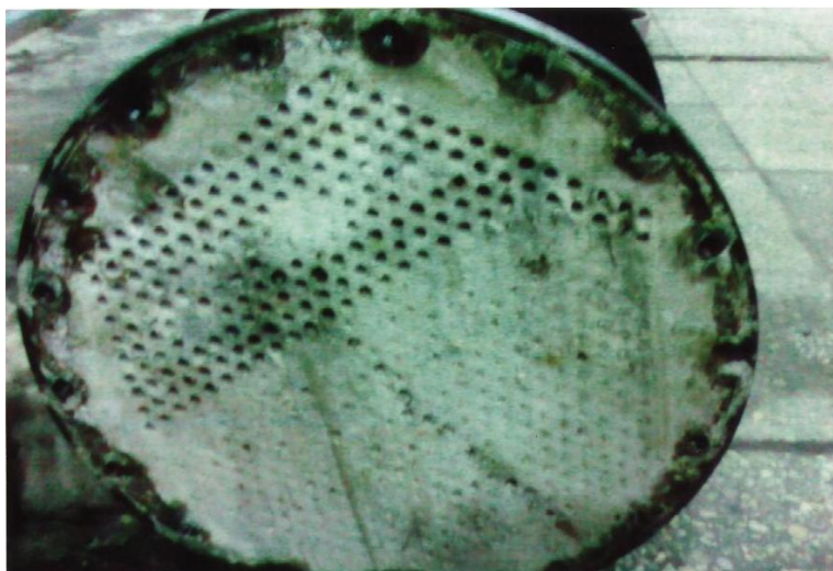
Рис.3. Маслоохладитель с расходом сетевой воды 4 \text{ м}^3/\text{ч} после 6 месяцев эксплуатации
