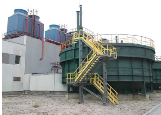
Рис. 3. НЛМК. Отстойник-флокулятор с технологическим диаметром 12 м с номинальной производительностью до 2200 \text{ м}^3/\text{час} .
