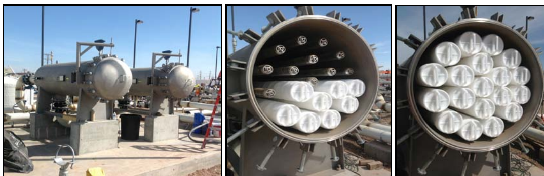
Рис. 5. Установка спаренных фильтродержателей для 60-дюймовых фильтропатронов 3М™ High Flow общей производительностью 4315 кубометров в час (фото слева), вид одного из этих корпусов с частично установленной зарядкой (в центре) и с полностью установленным комплектом патронов (справа).
