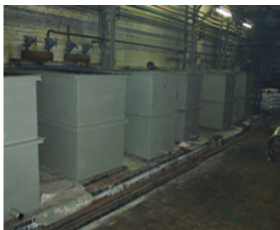
Фото 2 Гальванический цех: - ванна, защищенная «Ремохлор». - ванны, которые внутри защищены «Ремохлор», снаружи «Унитек»
