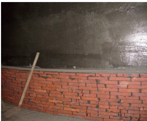
Фото 1 Емкость под водные пульпы \text{NaCl-RCl} , защищенная «Ремохлор». Днище и часть борта емкости дополнительно защищены футеровкой для удобства чистки от осадков
