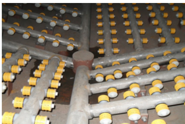
Рис.4 Нижнее дренажно-распределительное устройство ДО
