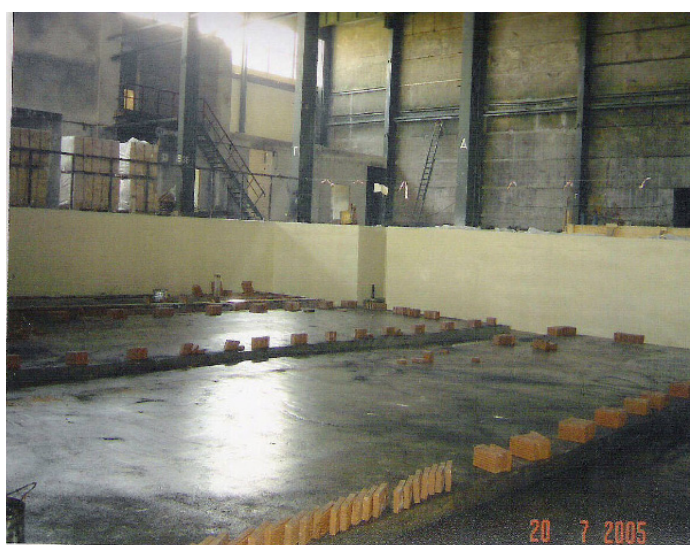
Фото 3 Поддоны ванн травления полосового металла, защищенные от протечек горячих кислот (серной или соляной с температурой до 90^{\circ}\text{C} )
