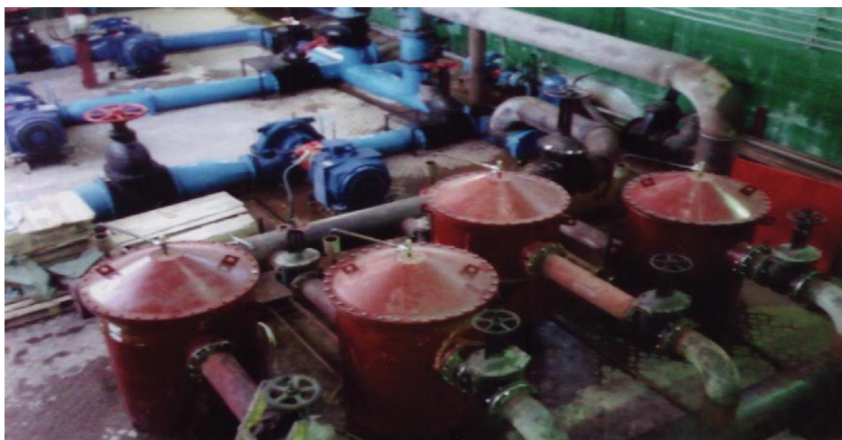
Рис.9. Электрохимические аппараты типа АЭ-А-350, установленные в оборотной системе производительностью 1000 м 3 /час
