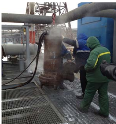
Рис. 2 Благодаря устройству напорного патрубка насос устанавливается в рабочее положение за несколько минут.
