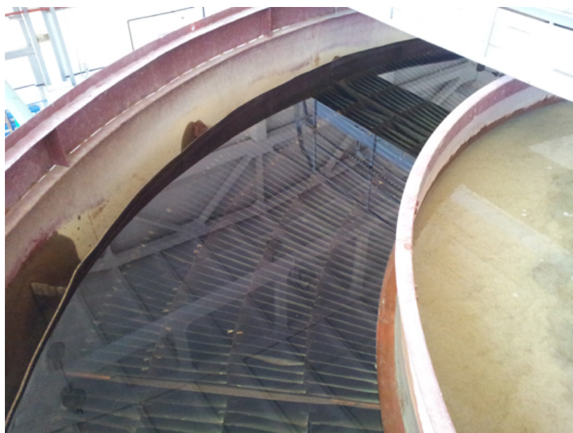
Рис.8. Сибайский филиал Учалинского ГОКа. Отстойник-флокулятор. Зоны флокуляции и седиментационного разделения фаз. Толщина слоя осветленной воды – 50 см.
