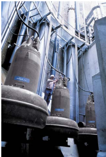
Рис. 3: Линейка погружных насосов на напорном патрубке ограничена производительностью 2000-2500 м 3 /час и давлением 0,8-1,0 Мпа.
